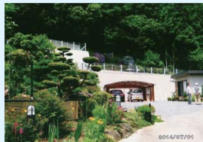
野津・栃原地区の急傾斜事業
