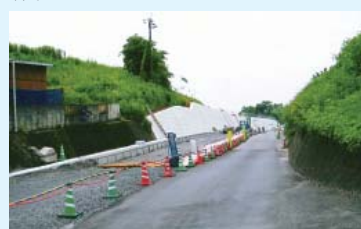
502号線都松工区改修工事
