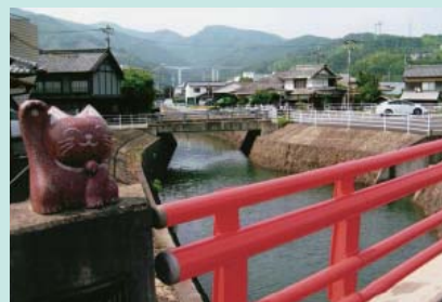
小河内川・温井川分流改修事業 新設の「赤猫橋」
